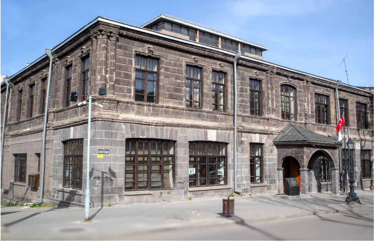
Fotoğraf 1: Serhat Kalkınma Ajansı Merkez Hizmet Binası
